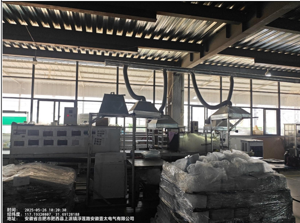
烘干机废气集气罩和收集管道
