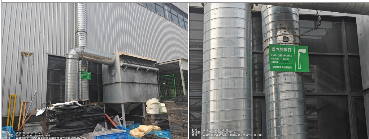
废料破碎，粉尘排气筒（DA005）
