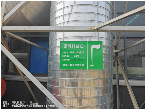
烫印废气集气罩和收集管道
