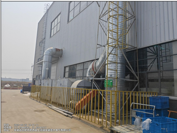
烘干机废气集气罩和收集管道
