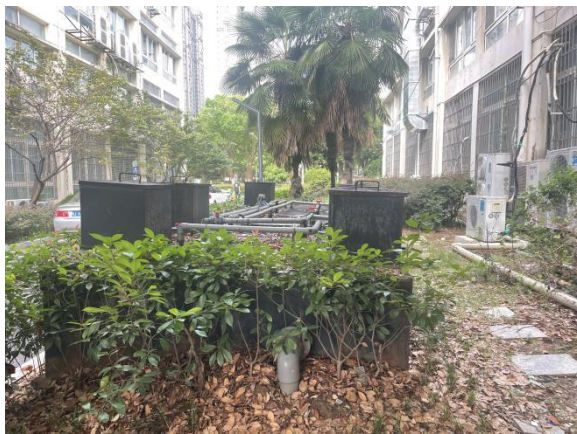
污水处理站现场勘察图
