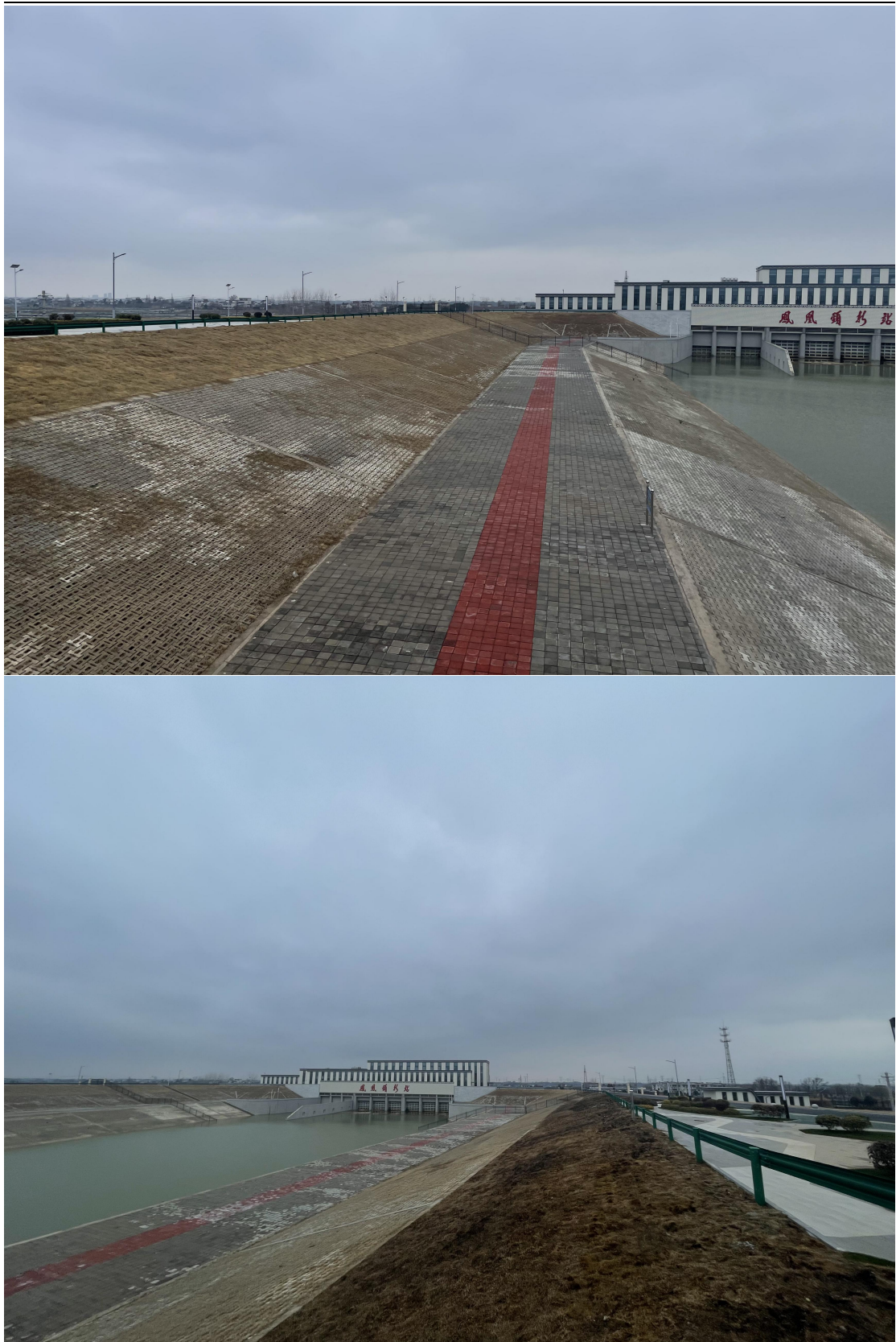
河道两岸护岸护坡
