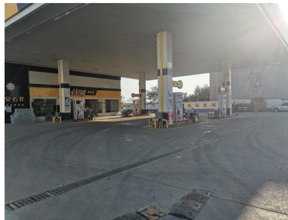
中安石化加油站
