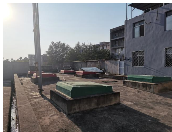
中安石化加油站
