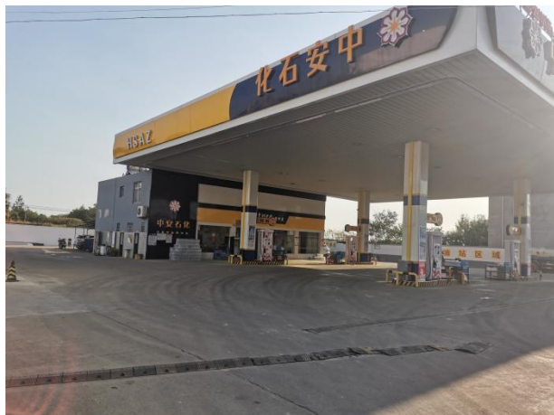
中安石化加油站
