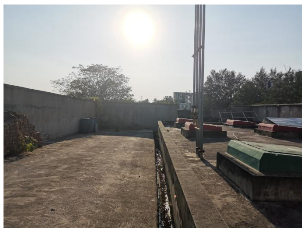
中安石化加油站
