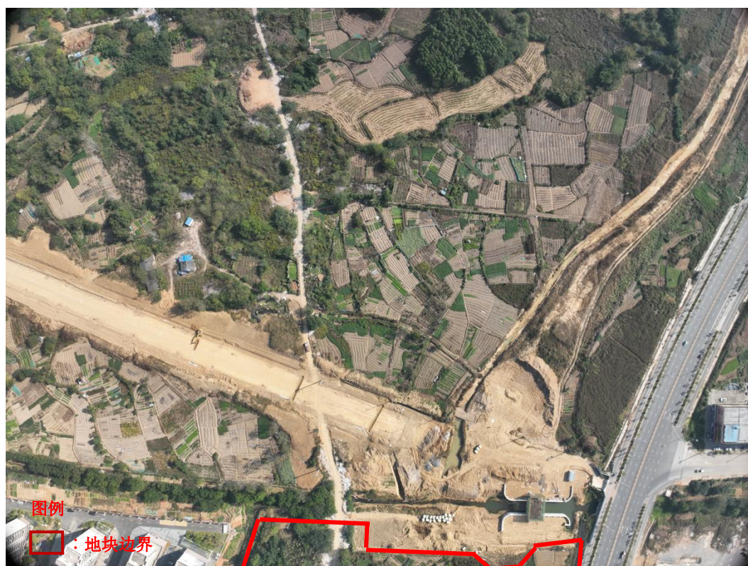
地块东侧航拍图（农用地、沟渠，在建道路）
